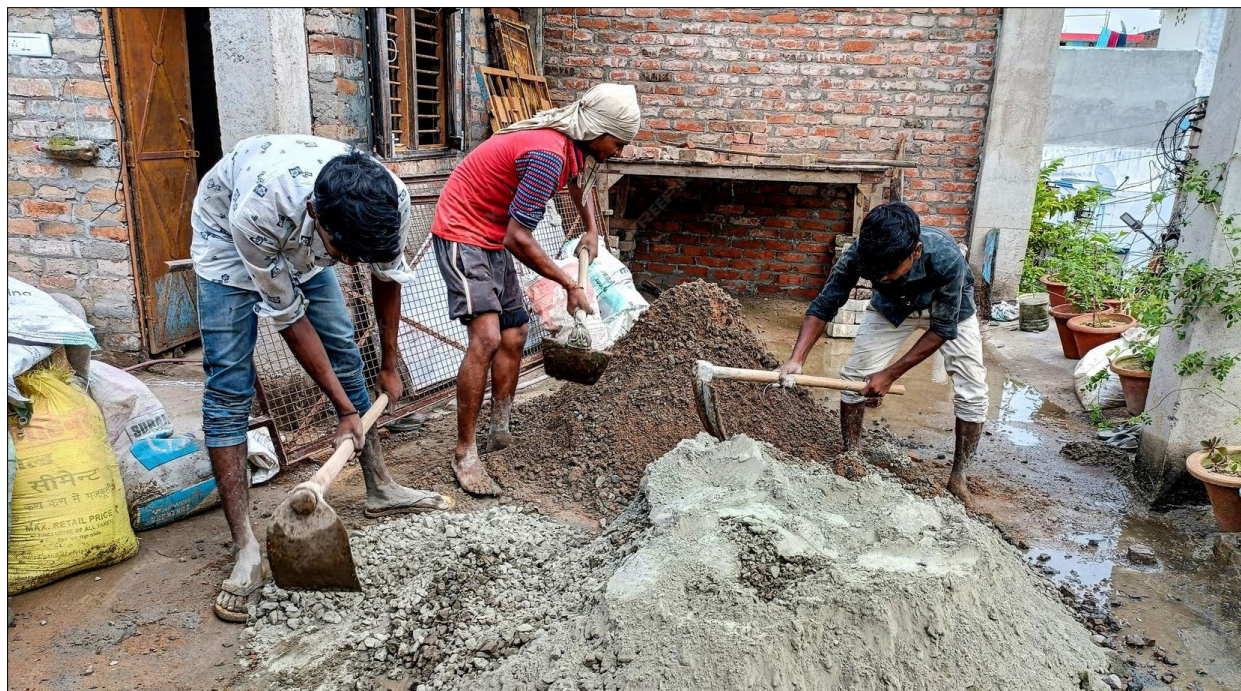
Bouwplaats in India
